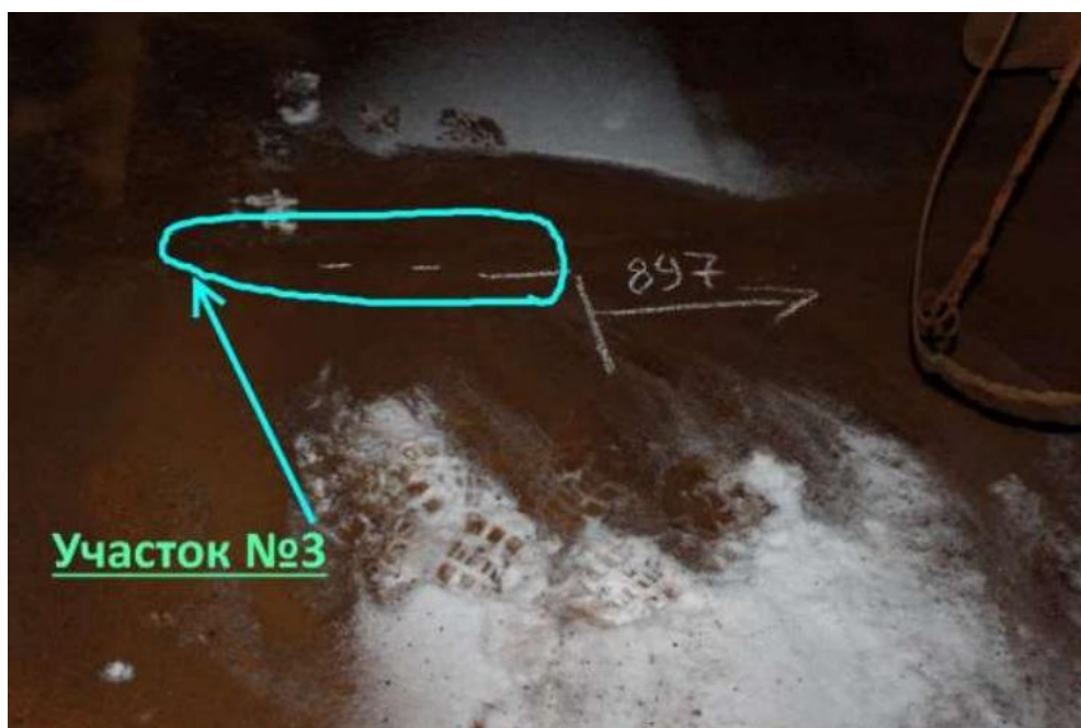
Рисунок 5. Участок № 3, временные прихватки на основном металле
