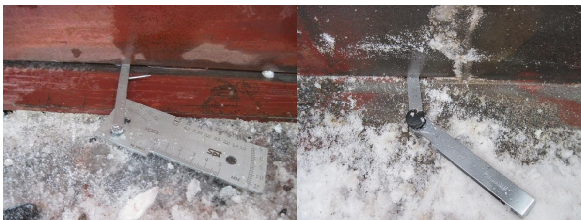
Рисунок 1. Завышенные зазоры
