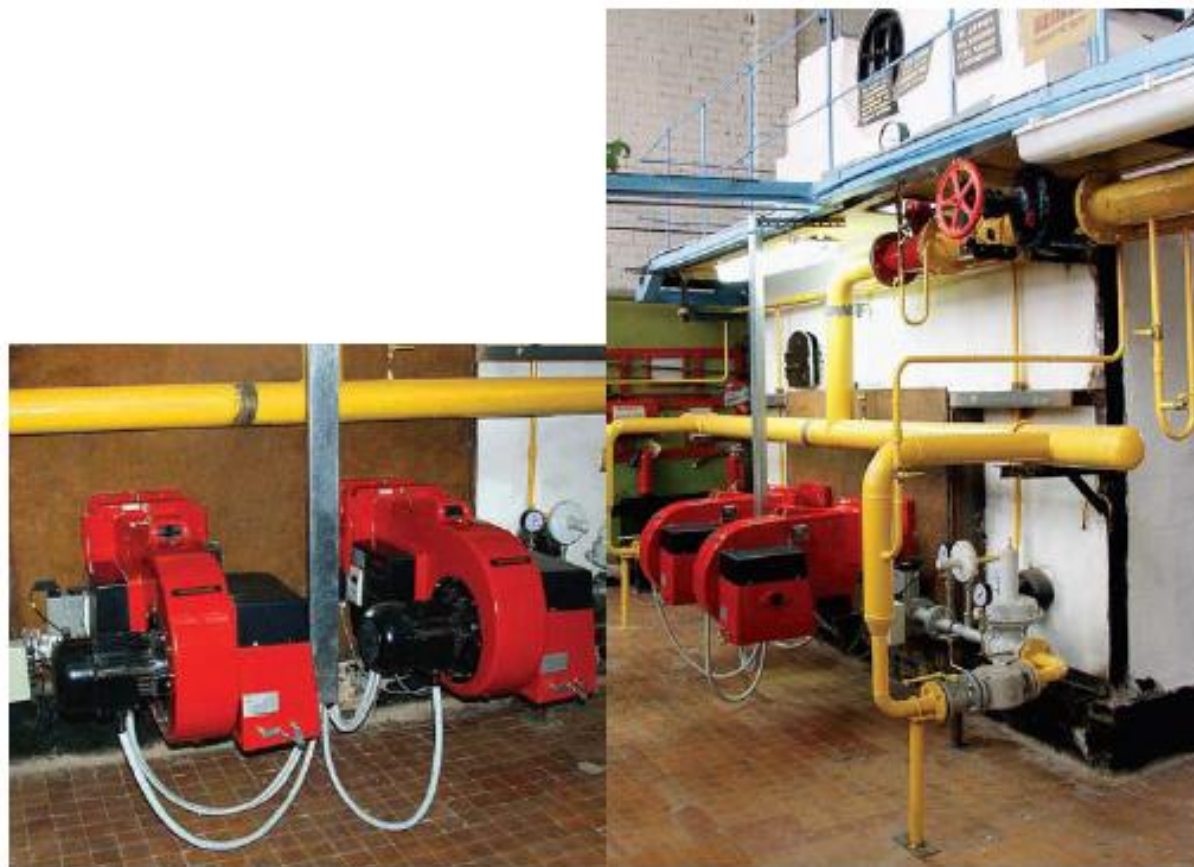
Рисунок 3. Установка горелки G40 на котле ДКВР-6,5
