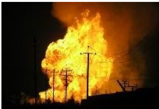
Рис. 4. Факельное воспламенение на 177 км магистрального газопровода.
