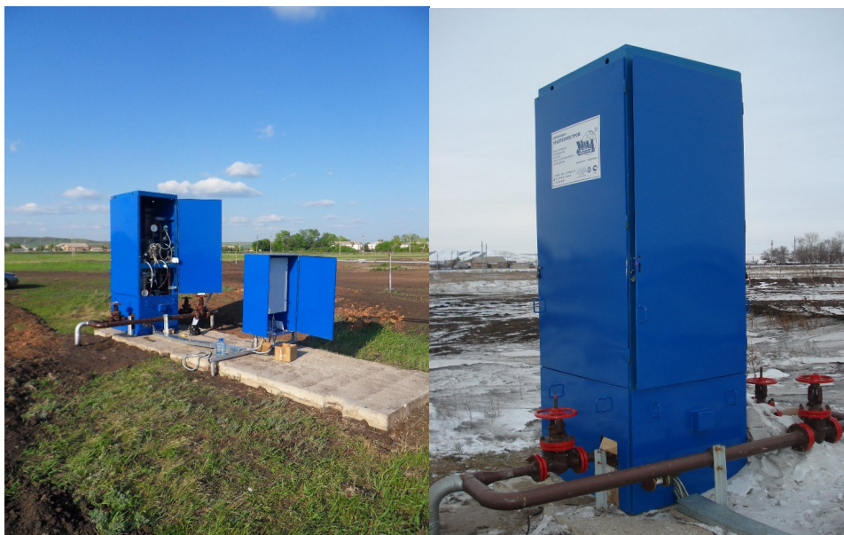
Рис. 3. Опытно-промысловые испытания ТриИУ на одиночной скважине: а – пуско-наладочные работы; б – мерный блок через 7 месяцев после начала испытаний
