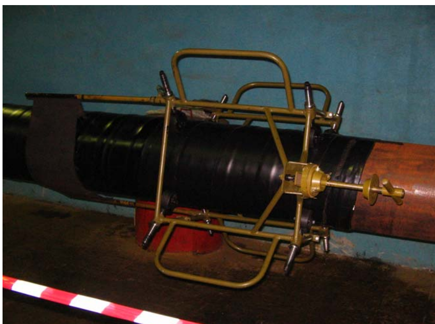
Рисунок 1. Устройство изоляционное типа «беличье колесо»
