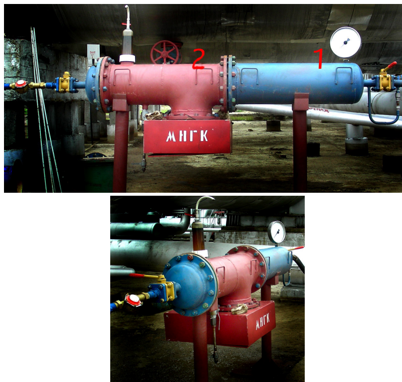
Рис. 1. Общий вид установки виброакустического воздействия: 1 – пустотелая секция; 2 – вибрационная секция
