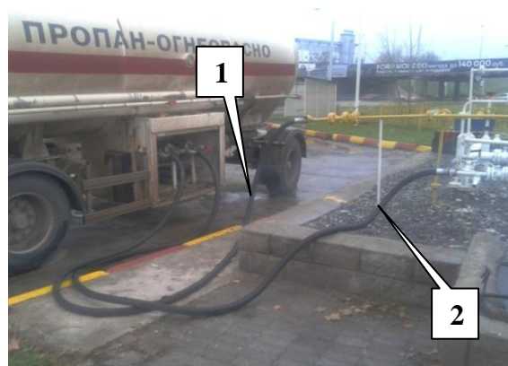
Рисунок 4. Наполнение АЦ из резервуаров: 1 – рукав для выравнивания паровой фазы СУГ; 2 – рукав для слива жидкой фазы СУГ
