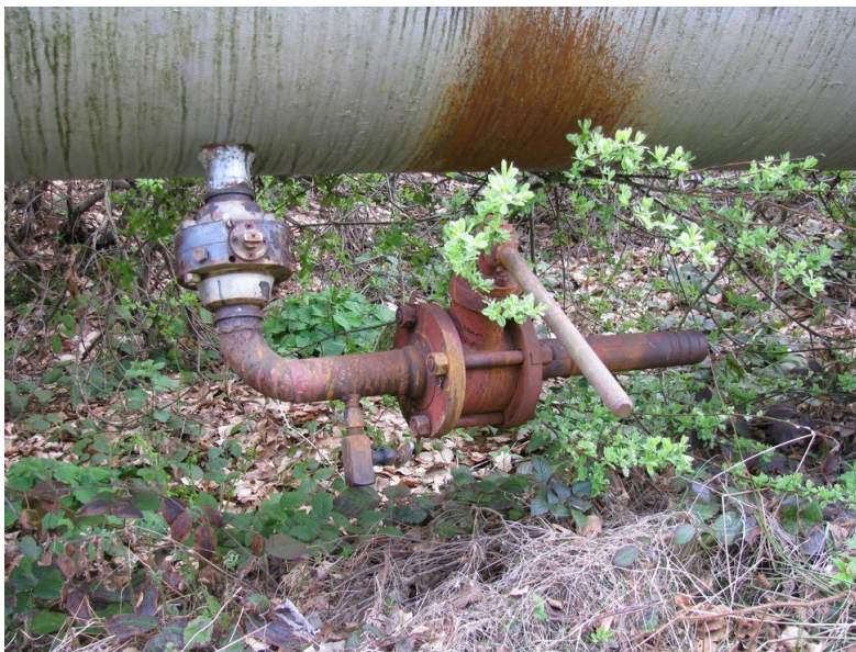
Рисунок 1. Врезка запорной арматуры в газопровод для дренажа жидкости
