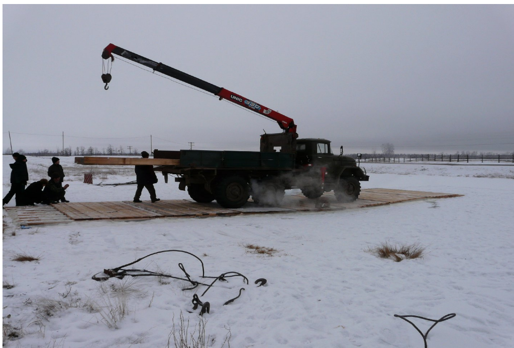
Рисунок 8. Усиление несущей способности болотистой местности
