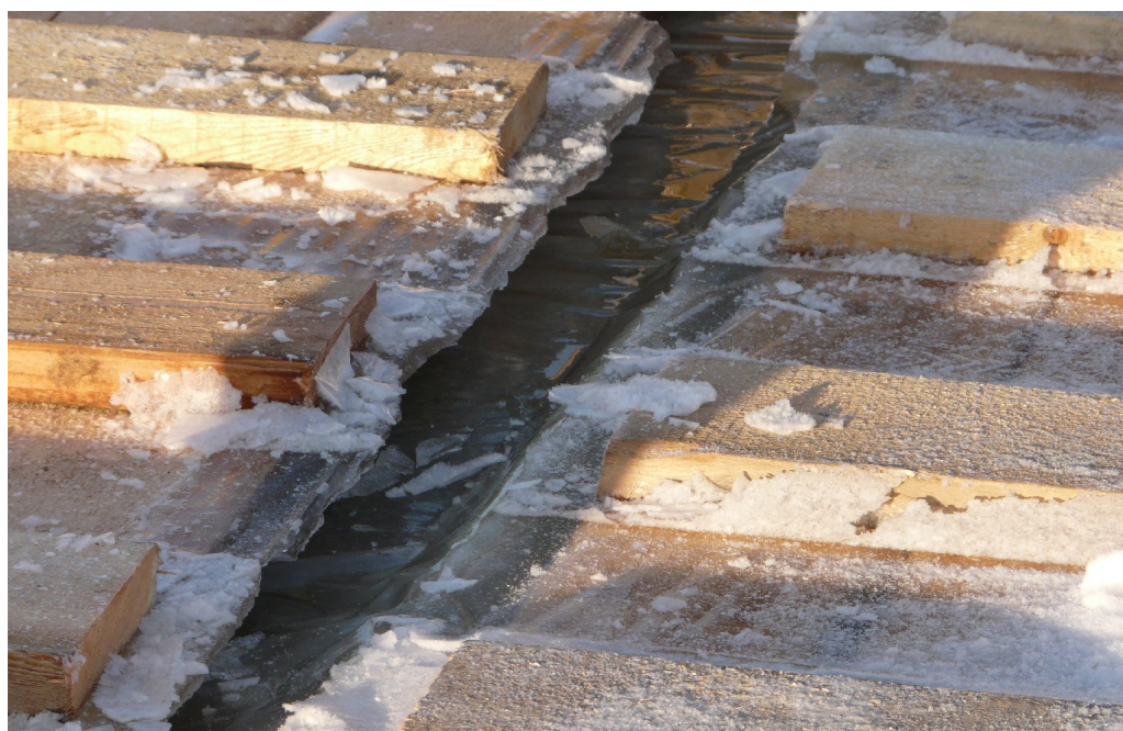
Рисунок 9. Сохранность деревянного настила при демонтаже
