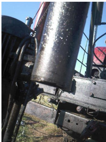
Рисунок 3. Слом резьбовой части патрубков подвешивания приставки насоса на скважине №2218
