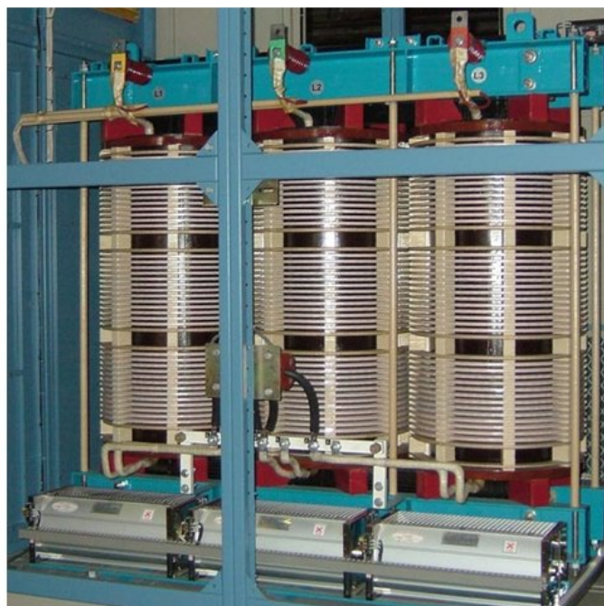
Рис. 3. Многообмоточный трансформатор
